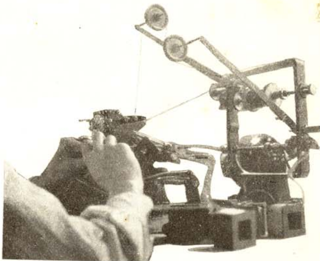
1. ábra. A transzformátorok tekercselése.
